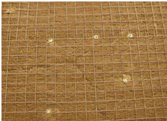
Bild 2: verdübelte AKS-Matte auf abgesandeter Epoxidharzgrundierung
