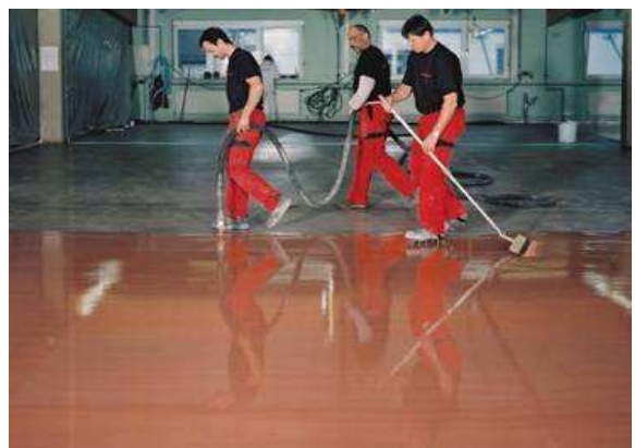
Bild 3: Einbau weber.floor 4650 DuroColour F 40
